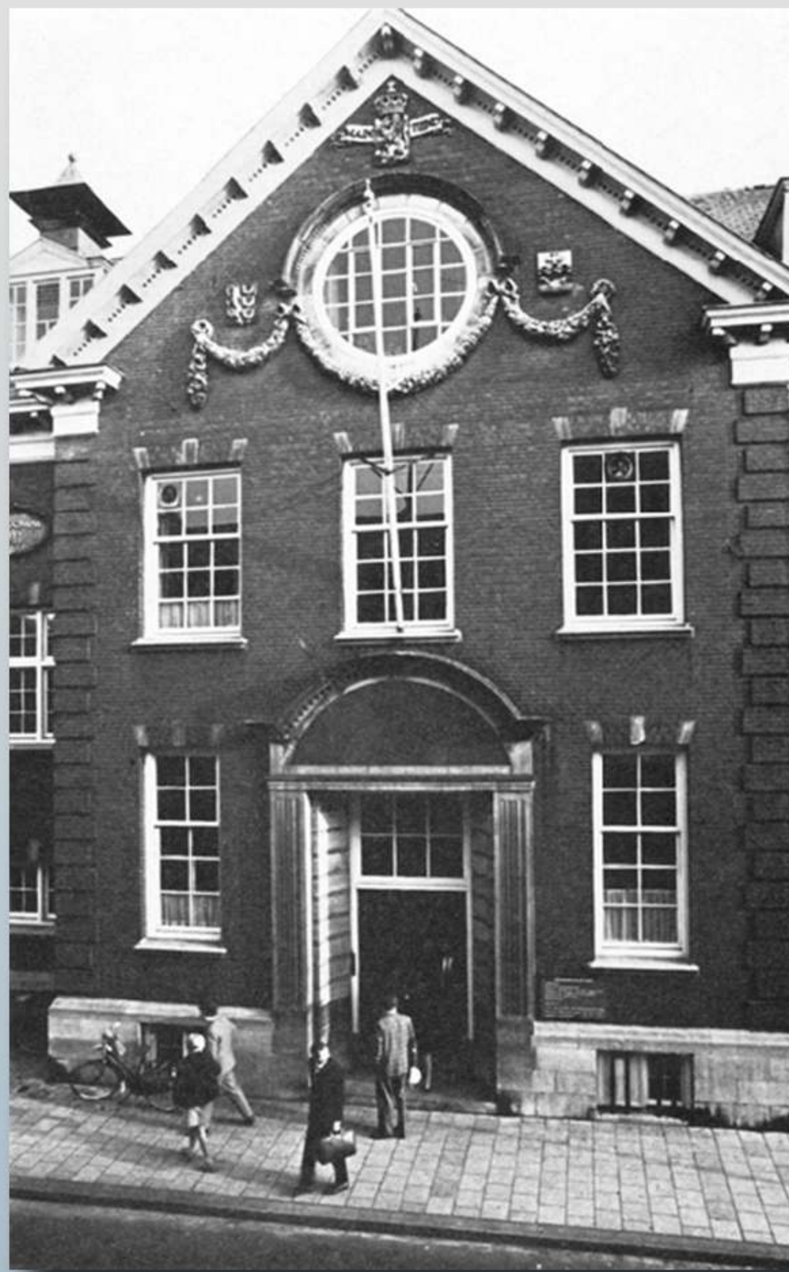
Het hoofdkantoor van de Coöp. Centrale Boerenleenbank op de Dommelstraat 9
