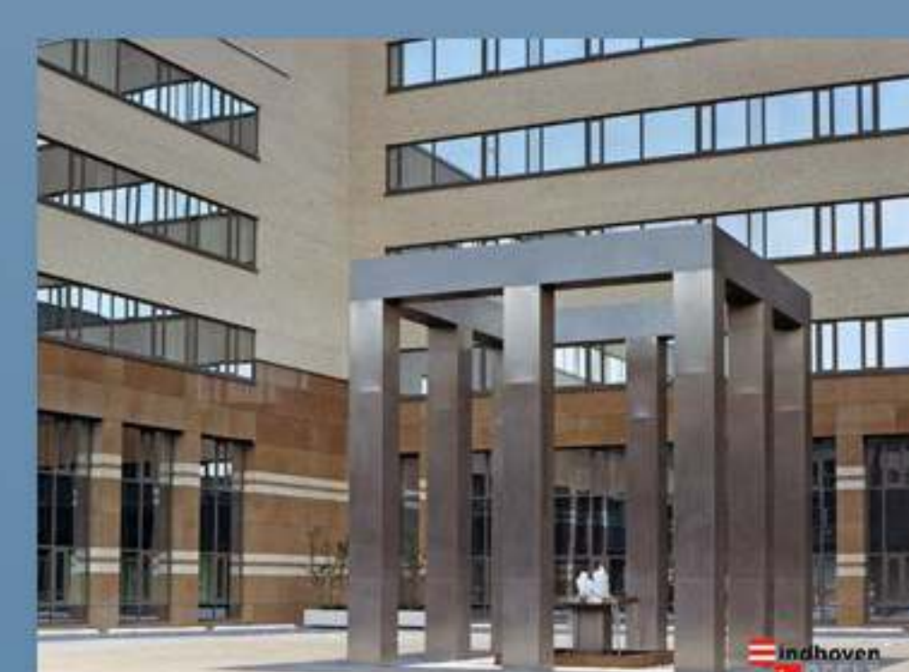
De Lage Landen op het Mignot en de Blockterrein.
